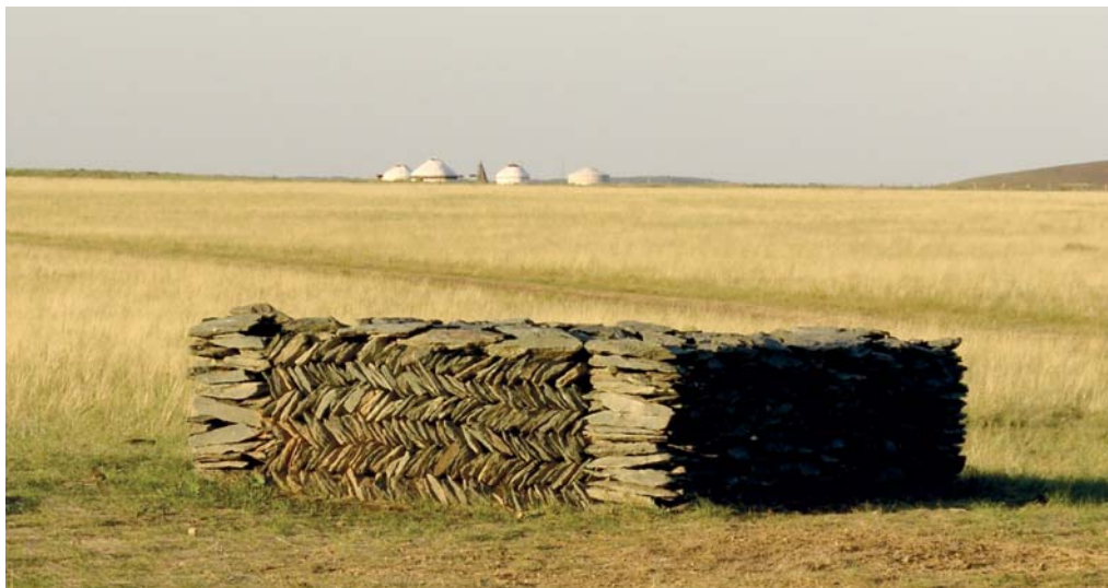
Рис. 3. Модель казахского кладбища в историческом парке заповедника «Аркаим». Каменная ограда с кладкой «в елочку». 2010 г.
