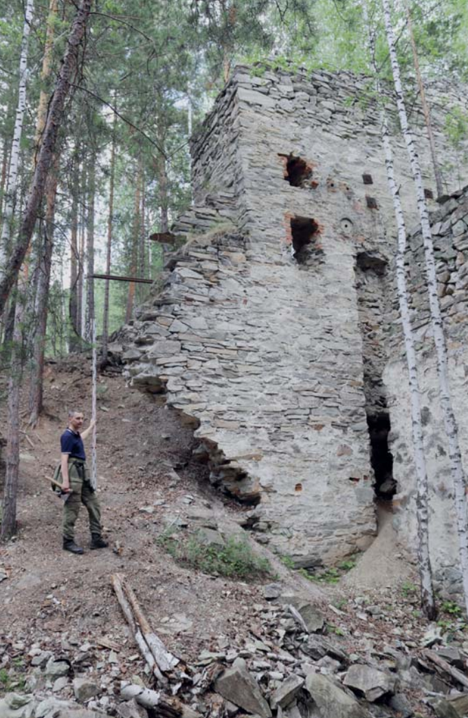
Рис. 4. Руинированное здание фабрики
